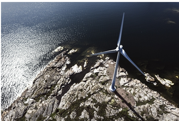
Maarianhaminan eteläpuolella, Båtskärin saaristossa, sijaitsee vuonna 2007 rakennettu tuulivoimapuisto.
